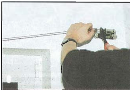
8 Протянув трос к другому кронштейну и обрезав его, монтируют стопор и ввертывают в кронштейн втулку, натягивая тросик.
