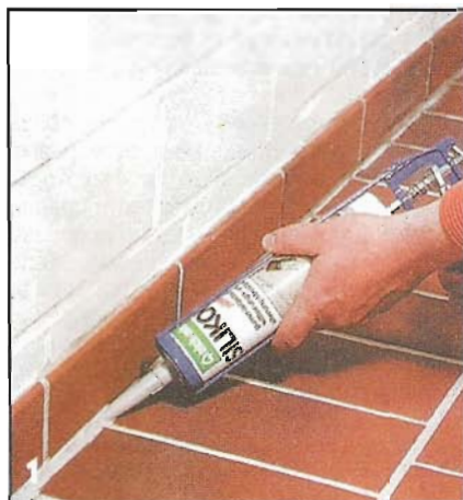
В деформационные или соединительные швы между плитками пола и цоколя выдавливают из картриджа непрерывный валик силиконового герметика.
