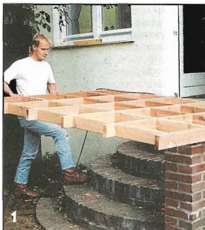
Для разметки положения настенного бруска и основных опор раму помоста кладут на место, выставляют горизонтально по уровню и фиксируют технологическими подпорками.
