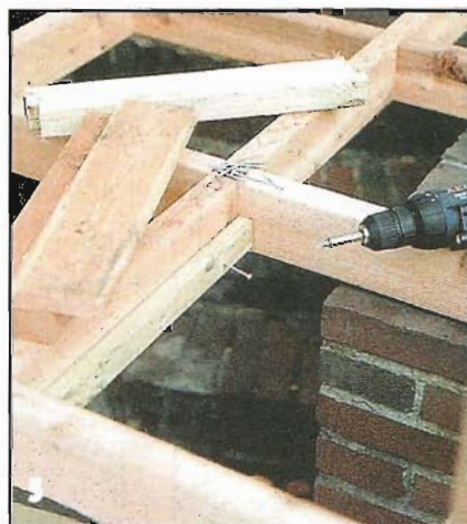
В каждой ячейке рамы по периметру монтируют на шурупах опорные планки сечением 19x50 мм. Располагают планки так, чтобы поверхность помоста после укладки плит была ровной.
