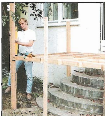
Настенный брусок крепят к стене шурупами с металлическими дюбелями, подложив под него полосу рубероида для гидроизоляции. В прилегающей к стене опоре выбирают пазы под настенный брусок и отлив окна.
