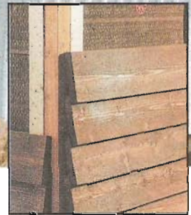
Обшивка внахлест из нестроганных досок смотрится более грубой в сравнении с обшивкой внахлест из шпунтованных досок с выкружкой. Впрочем, защитная краска или лазурь проникает в поры нестроганных досок лучше, чем в строганные пиломатериалы.
