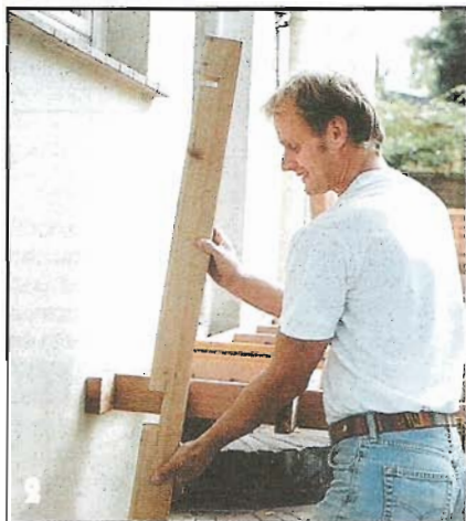
Настенный брусок крепят к стене шурупами с металлическими дюбелями, подложив под него полосу рубероида для гидроизоляции. В прилегающей к стене опоре выбирают пазы под настенный брусок и отлив окна.
