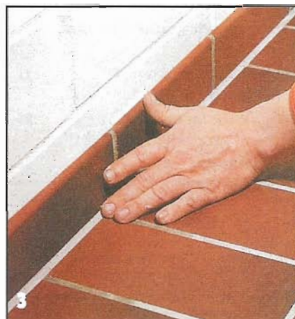
... и разравнивают пальцем. Чтобы герметик не прилипал к пальцу, его смачивают моющим средством.
