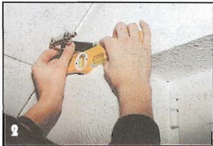
2 Положение кронштейнов тщательно выверяют и на стене размечают центры крепежных отверстий.
