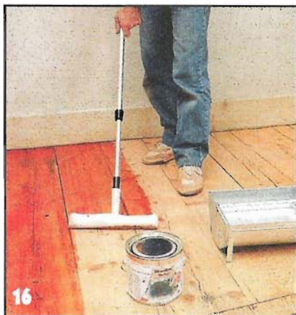
С помощью швабры и тряпки нанесли масло на пол равномерным слоем.
