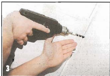
3 Отверстия для дюбелей сверлят перфоратором. Панели обшивки потолка предварительно укрывают куском картона.
