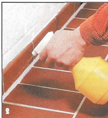
Затем смачивают герметик водой ...
