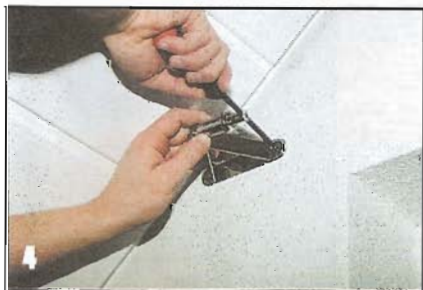
4 В отверстия забивают дюбели, а в последние ввинчивают шурупы, крепящие кронштейн.
