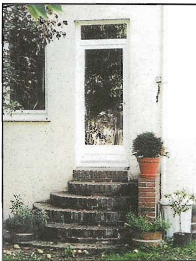
Старое кирпичное крыльцо требовало ремонта. Обновить его удалось неожиданным образом.
